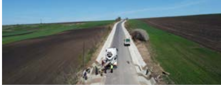
DJ 294A, Avrămeni – Panaitoia – Dimitrie Cantemir
